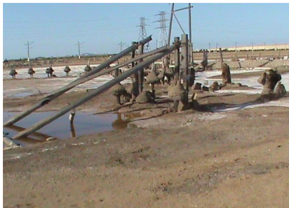
Şəkil 1. Yod-brom zavodunun tikinti qalıqları ilə çirklənmiş hissəsi
